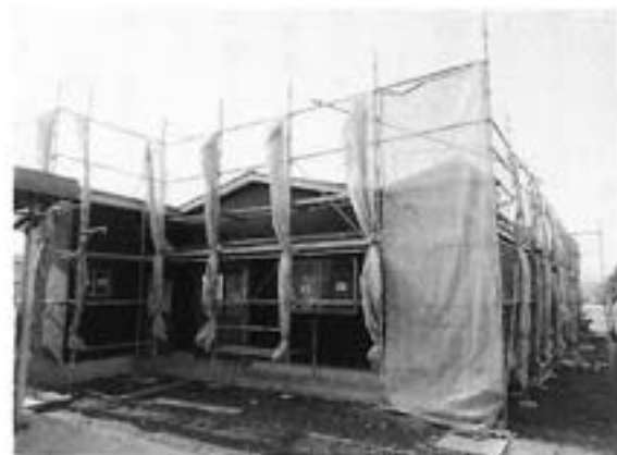
新事務所建設中 3月完成予定
