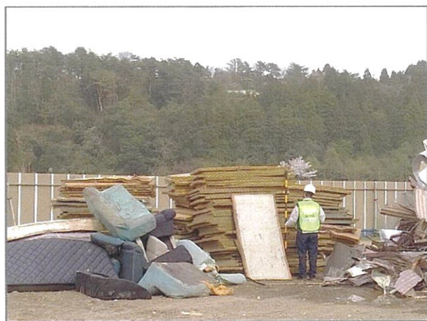
仮置場設置の技術的助言（穴水町）
